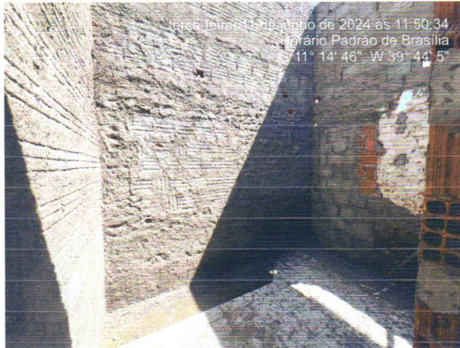
Foto 07 – CHAPISCO APLICADO EM ALVENARIA (COM PRESENÇA DE VÃOS) E ESTRUTURAS DE CONCRETO DE FACHADA, COM EQUIPAMENTO DE PROJEÇÃO. ARGAMASSA TRAÇO 1:3 COM PREPARO EM BETONEIRA 400 L. AF_06/2014
