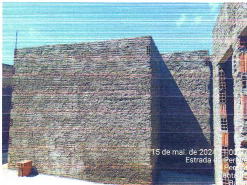
Foto 06 – CHAPISCO APLICADO EM ALVENARIA (COM PRESENÇA DE VÃOS) E ESTRUTURAS DE CONCRETO DE FACHADA, COM EQUIPAMENTO DE PROJEÇÃO. ARGAMASSA TRAÇO 1:3 COM PREPARO
