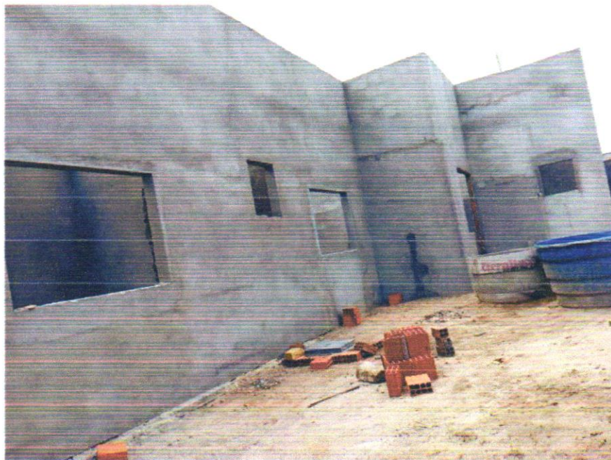
Foto 08 – MASSA ÚNICA, PARA RECEBIMENTO DE PINTURA OU CERÂMICA, ARGAMASSA INDUSTRIALIZADA, PREPARO MECÂNICO, APLICADO COM EQUIPAMENTO DE MISTURA E PROJEÇÃO DE
